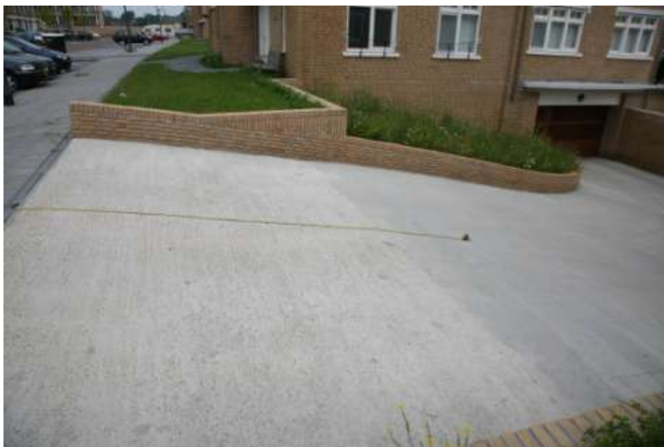
Foto 8 – Hellingbaan 3, extra opgestort gedeelte aan de bovenzijde
