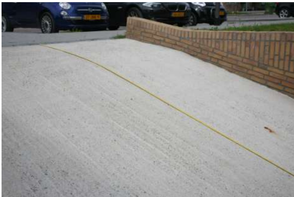
Foto 5 – Hellingbaan 1, extra opgestort gedeelte aan de bovenzijde en overgangshelling
