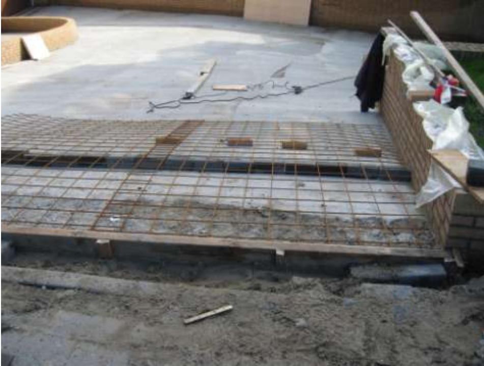
Foto 3 – Hellingbaan 1, extra opgestort gedeelte aan de bovenzijde (in uitvoering)
