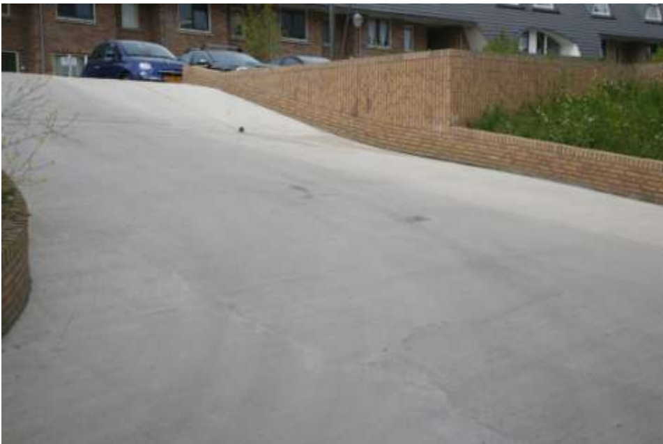
Foto 4 – Hellingbaan 1, extra opgestort gedeelte aan de bovenzijde
